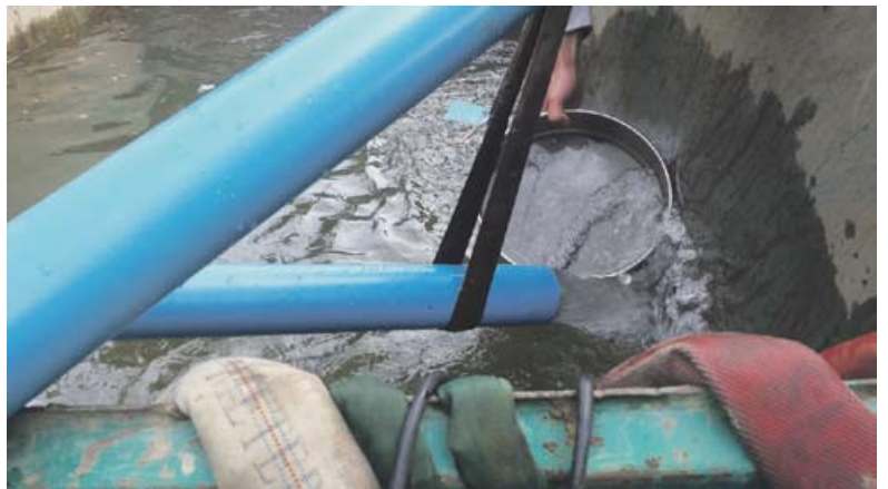
Mangan wird aus dem Brunnen ins Absetzbecken gespült: Nach mehreren Reinigungs- und Kontrolldurchgängen ist das Wasser wieder klar.
