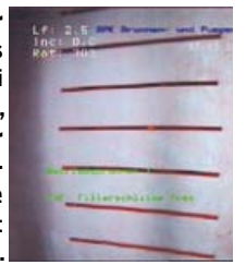
Erhebliche Ablagerungen an der Brunnenwand vor der Sanierung: Teils vollständig verschlossene Filterschlitze.
