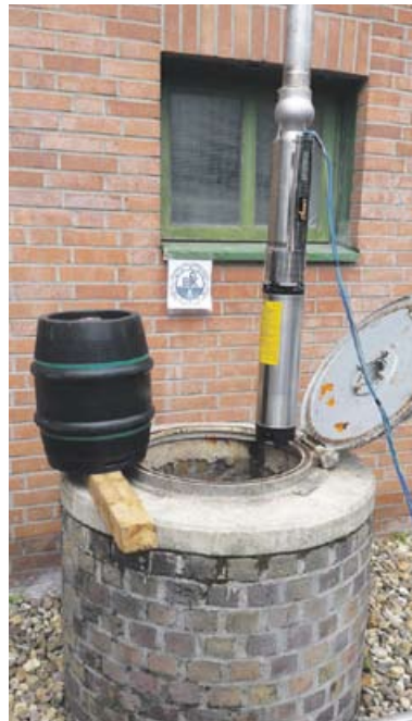
Einfahren der Pumpe samt Steigrohr in den Brunnen: Der letzte Arbeitsschritt vor der Wiederinbetriebnahme.
